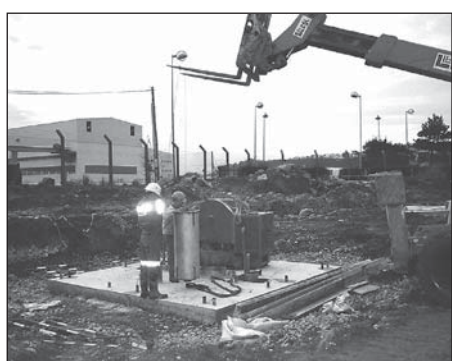
Figure 10. Remplacement d'un filtre
