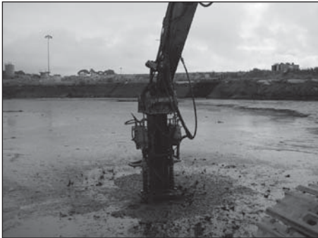
Figure 7. Traitement in situ de la lagune
